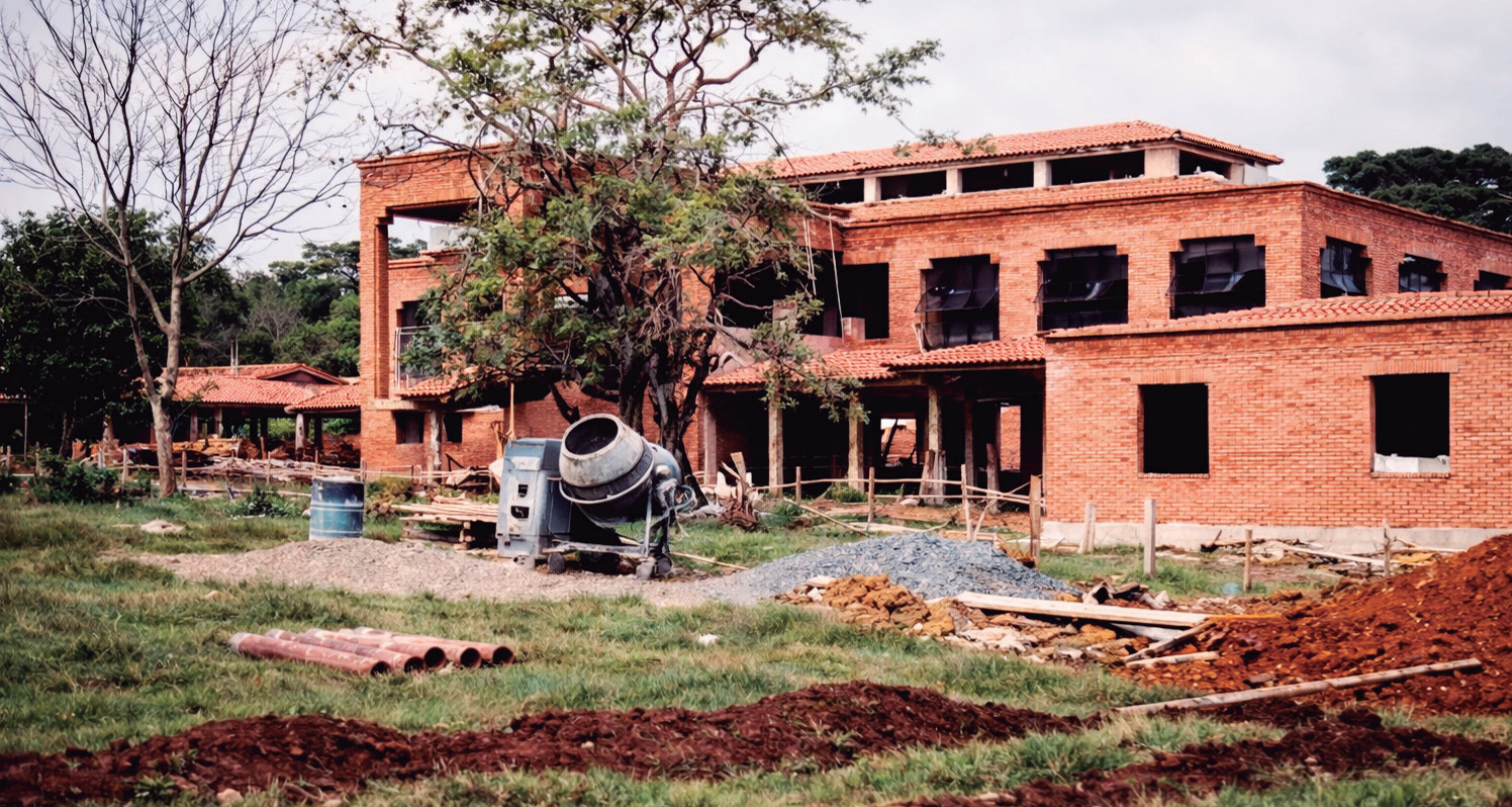
Construcción de la sede Pance 1995
