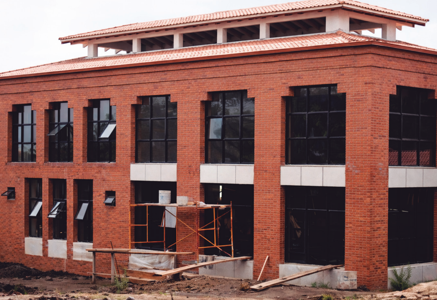
Construcción de la sede Pance 1995
